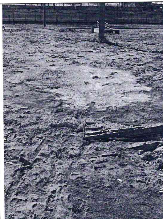
Рис.19. Миксеры с бетоном заываются после опорожнения на грунт.
