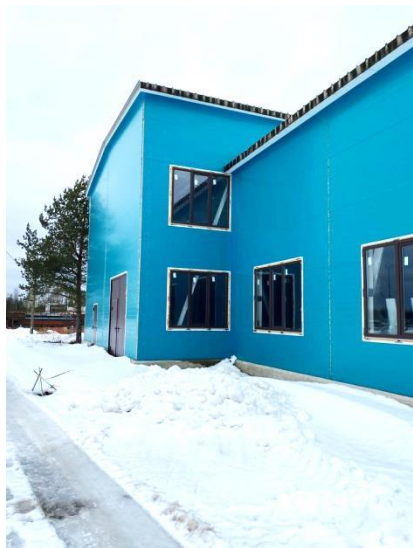
КОС г. Тосно – строительная готовность 96%
