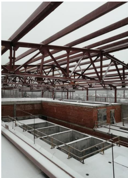
Металлоконструкции кровли и флотофильтры
