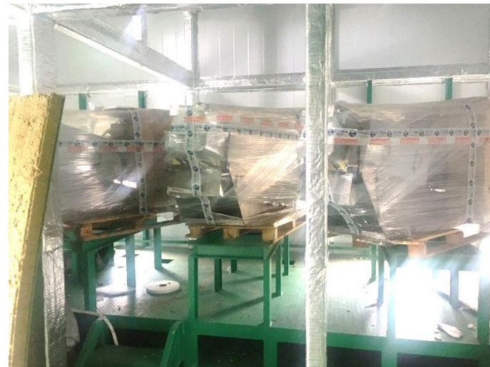
Реконструкция КОС п. Красносельское – строительная готовность 96%
