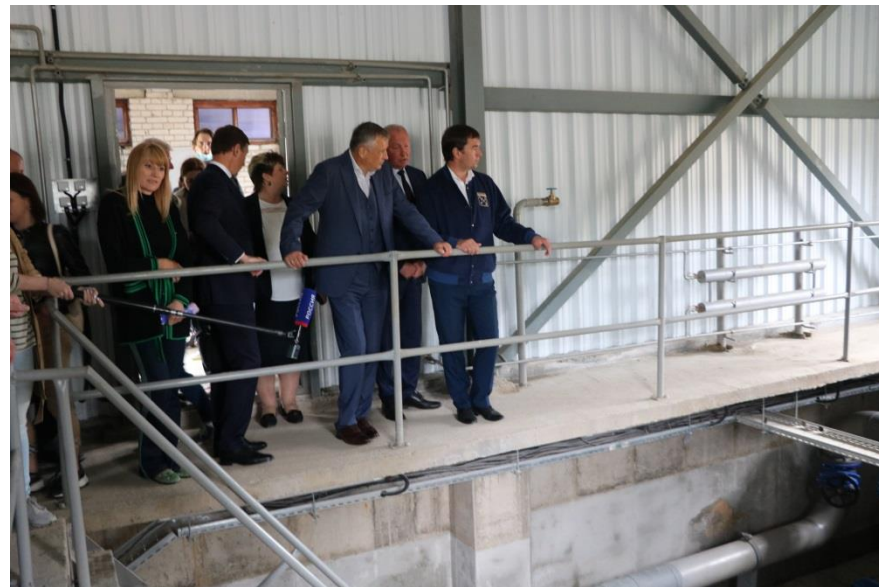
2 нитка водовода от ВОС г. Всеволожска до ВНС пос. Романовка – строительная готовность 96%
