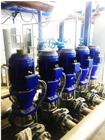
Реконструкция сетей водоснабжения в дер. Бегуницы – строительная готовность 98%
